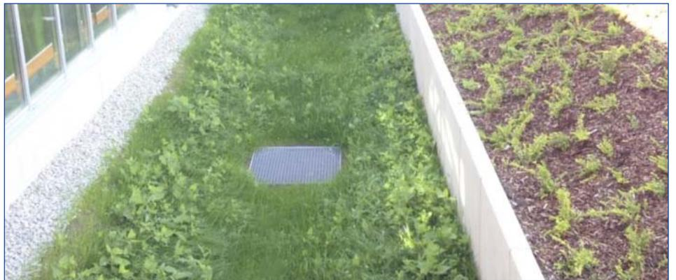
Fertige Mulde mit Quellrohr und Anschluss des Einzugsgebietes, „Verkehr-2“ über eine Hebeanlage.
