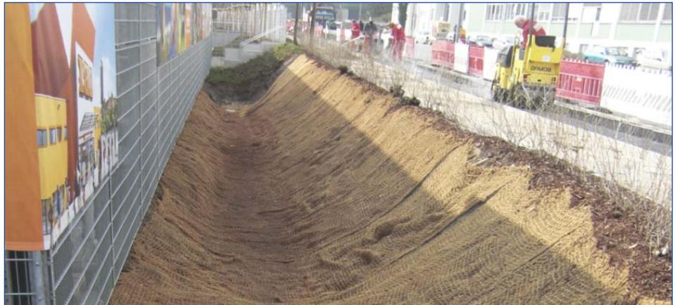
Fertige Mulde mit Quellschacht und Edelstahl einlaufrost zur Erhöhung des Einlaufquerschnittes.
