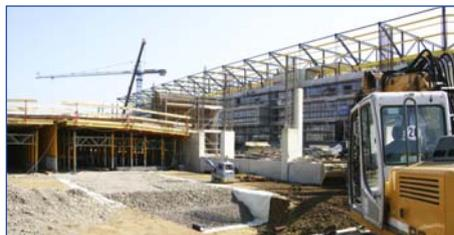
Bild rechts: Herstellung des flächigen GEO PROTECT®-Tragschichtspeichers unterhalb des Spielfeldes.
